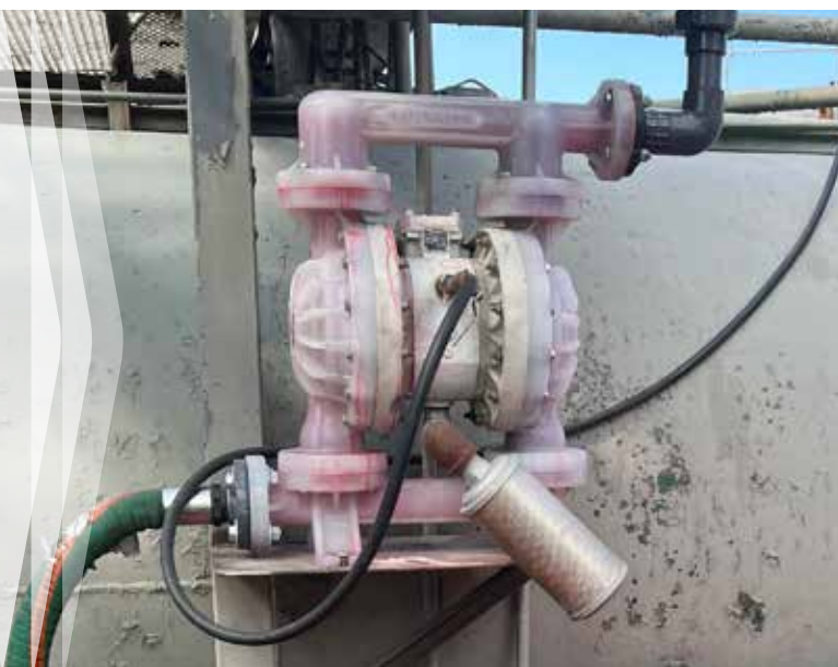
Une hauteur d'aspiration élevée réduit le débit de la pompe.
