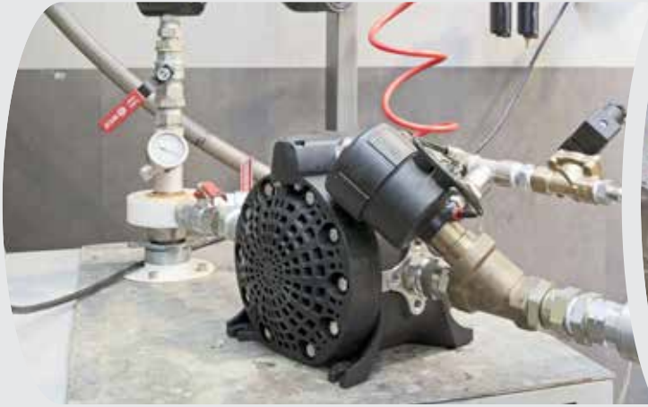
Dosage d'additif de ciment.
